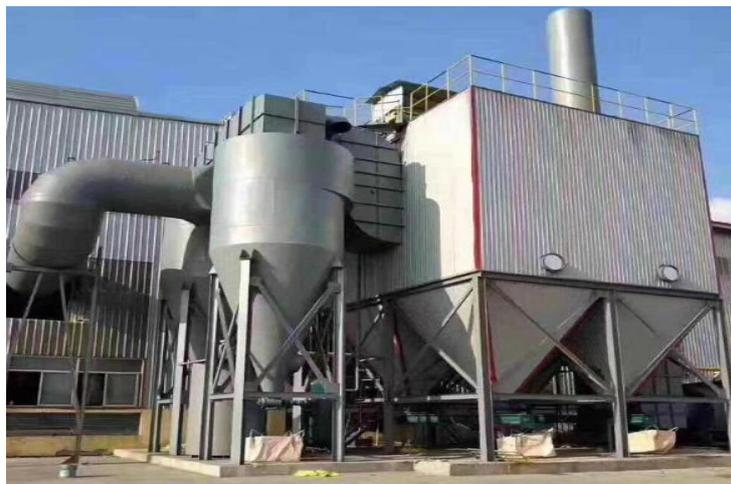
图4-2 废气处理设施示意图
